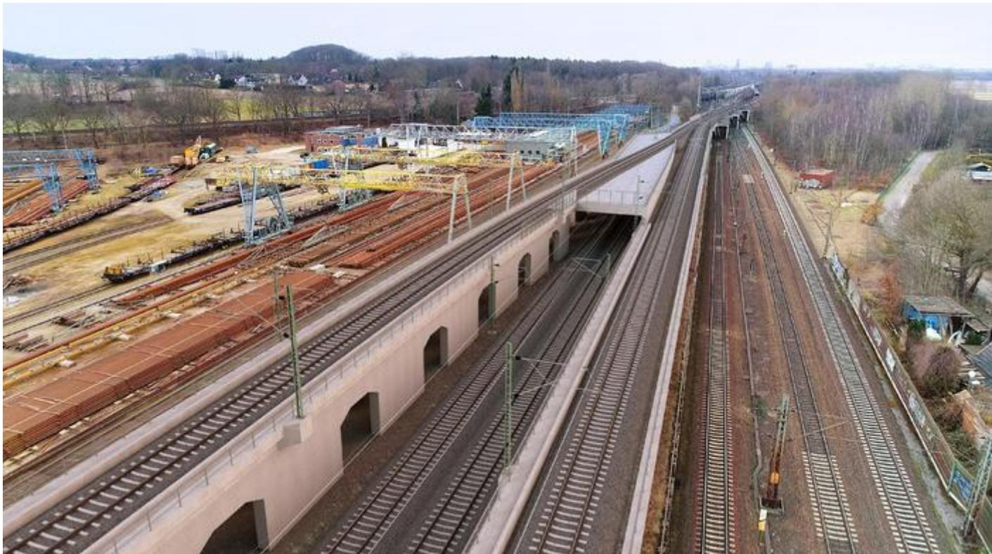
Computervisualisierung, Blickrichtung Harburg: Das bestehende Überwerfungsbauwerk im Hintergrund soll um eine weitere Rampe in Höhe des Vossloh-Betriebsgeländes (links) erweitert werden. Deutsche Bahn/DB
